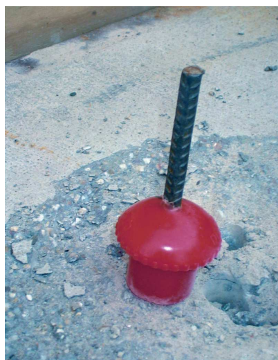
De paddestoel D10 mag beslist niet gebruikt worden voor verticale beveiliging.
