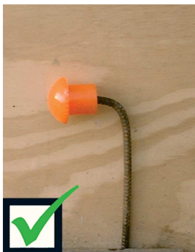
De paddestoel D10 is er alleen voor horizontale stootbeveiliging.
